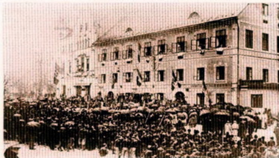
Fašistično zborovanje v Idriji. Sedanji trg maršala Tita se je imenoval „Piazza Vittorio Emanuele III.“ V prizidku stavbe št. 3 je bil sedež občinskega vodstva fašistične stranke.
